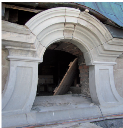
Steinaustausch an Fenster unter Turmhelm
