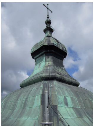
Instandgesetzte barocke Kupferhaut
